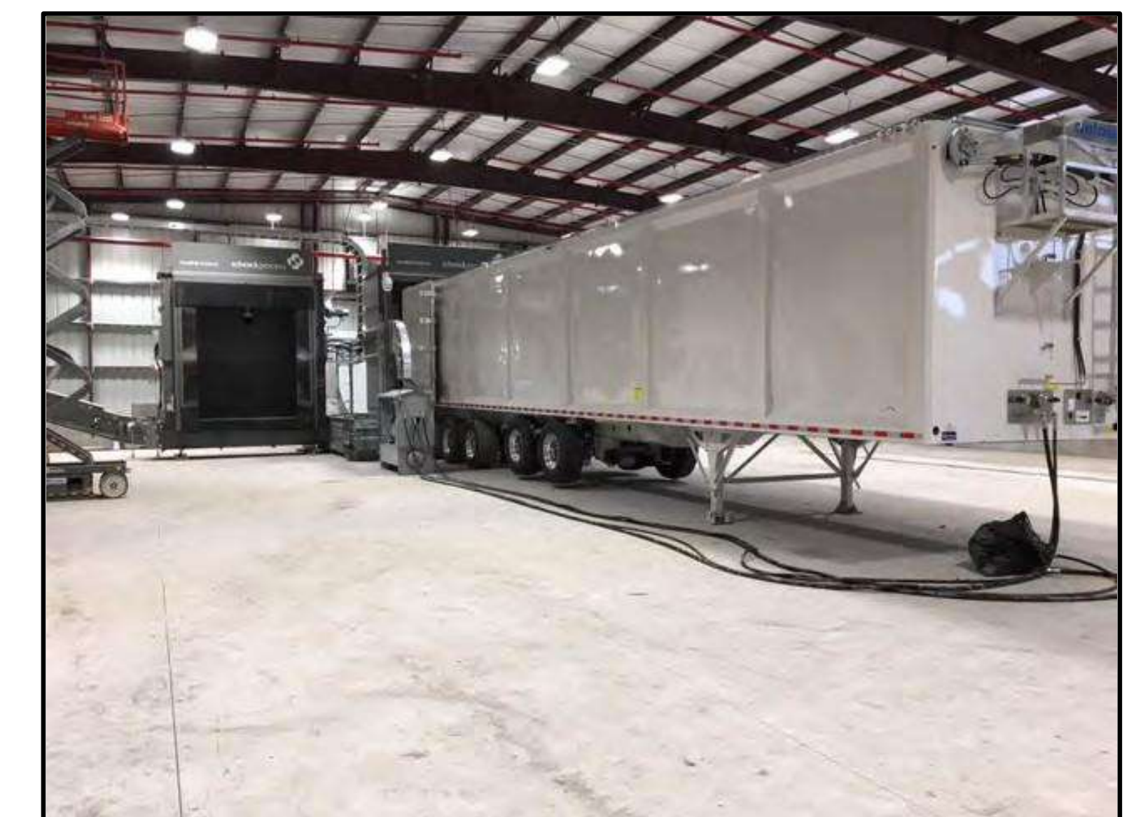
Conteneur de stockage fermé pour les CFTC
